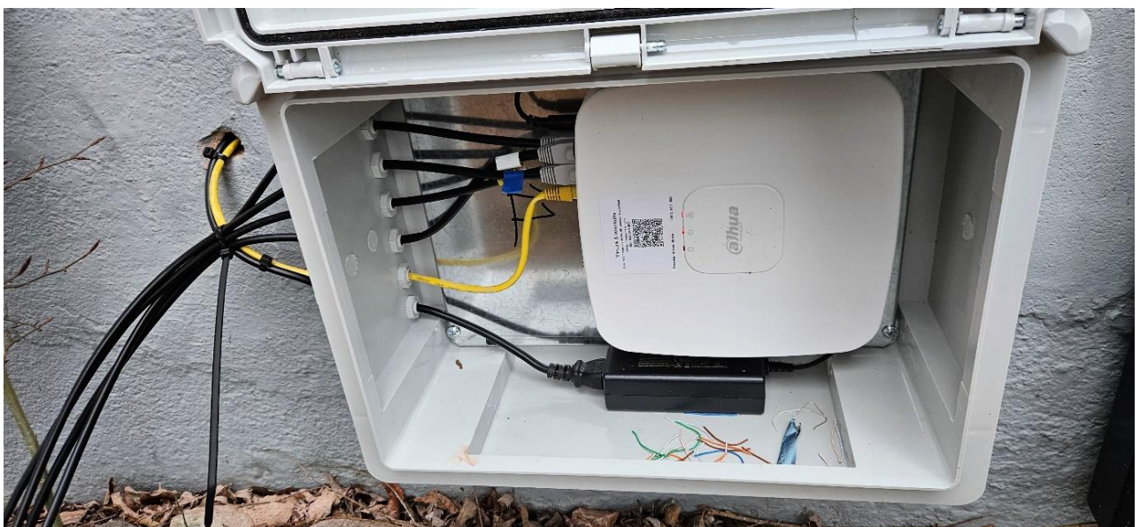
Figuur 2: De recorder met de UTP-kabels die naar de camera's lopen.
